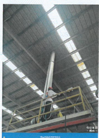
ZH2507ST02 项目名称: 晟通科技集团有限公司自行 监测项目 监测点位: Y10硫化钢排气管DA010 经度: 112.835437°E 纬度: 28.323189°N
